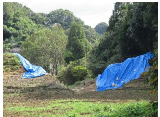
写真-1 貯水池法面側
