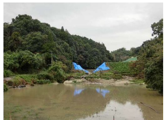
写真-2 下流法面側
